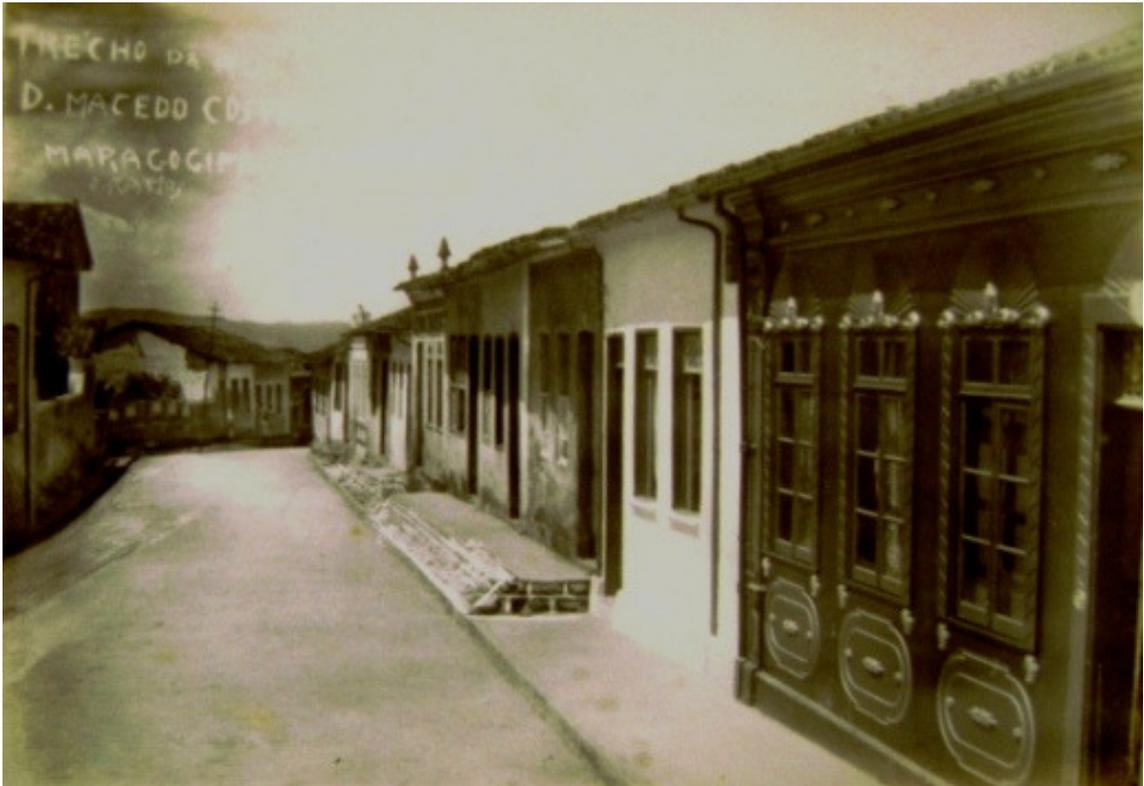
**Figura 11:** Trecho da rua D. Macedo Costa. Maragogipe. Nivelamento e calçamento a paralelos rejuntados a cimento, inaugurados em 1940.
