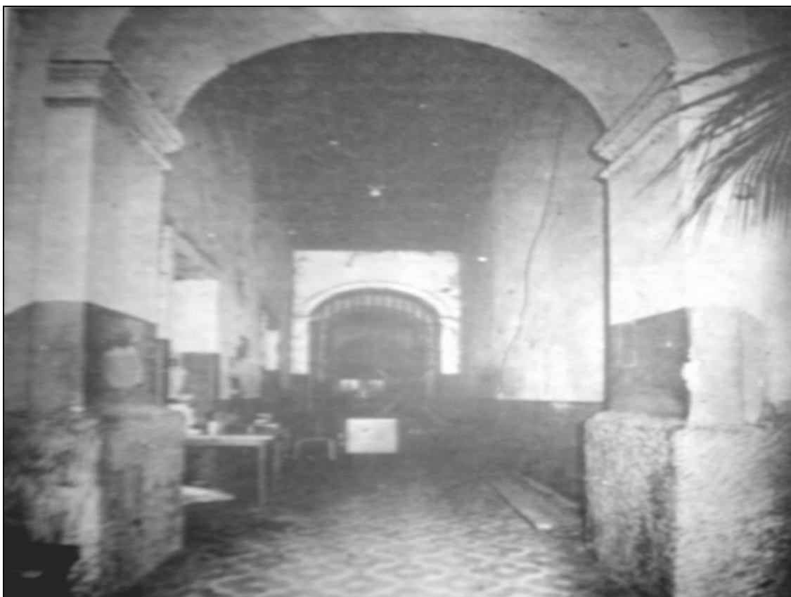
Ilustração 5: Entrada da Casa de Detenção de Teresina, localizada no Campo de Marte. Destruída na década de 70 para a construção do Ginásio Verdão.
