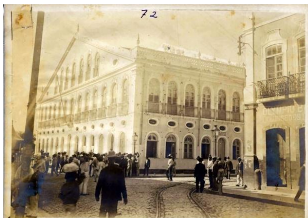
Figura 10 - Diretoria de Rendas da Bahia. Curiosos contemplam o prédio perfurado por balas após o bombardeio e intervenção federal no estado. Salvador, 1912. Fonte: sítio do APM.
