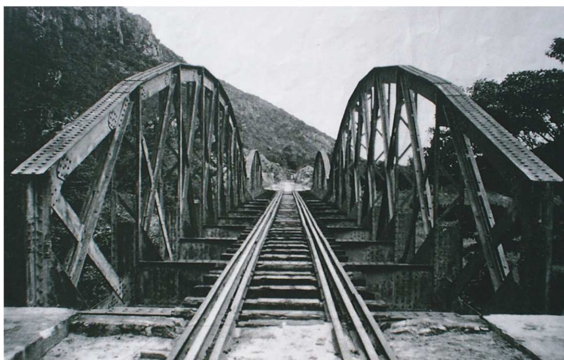
Figura 9: pontilhão de 50 metros em dois vãos sobre o rio Itapicurú-mirim na entrada da Jacobina. Todos os pontilhões com mais de 20 metros obedeciam a este padrão, onde a estrutura de aço era assentada sobre grossos muros de pedra unida com cimento.
