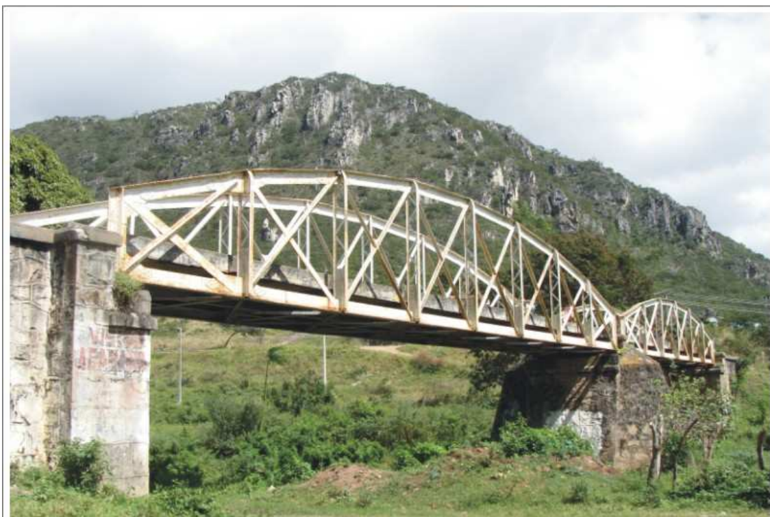
Figura 34: pontilhão de 50 metros sobre o rio Itapicurú-mirim na entrada de Jacobina. Trata-se do mesmo da figura 9 no capítulo II. Vê-se o piso em concreto feito para permitir o tráfego de automóveis.
