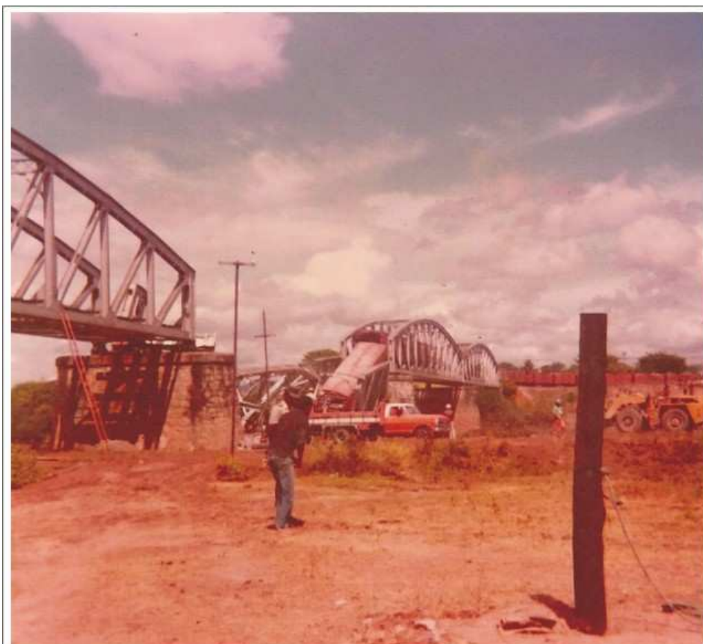
Figura 38: construção de desvio e ponte provisória para resgatar os vagões presos na outra margem do rio após o acidente de 1983. Iacú, março de 1984. Fonte: Projeto Iacú Cultural
