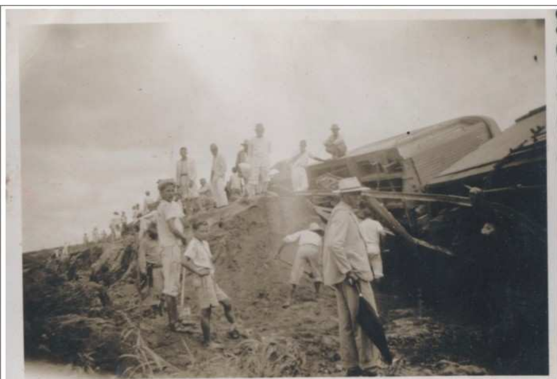
Figura 18: o trem “saiu”. Descarrilamento próximo ao povoado de Água Branca, Miguel Calmom, dezembro de 1947. Fonte: Acervo NECC/UNEB.
