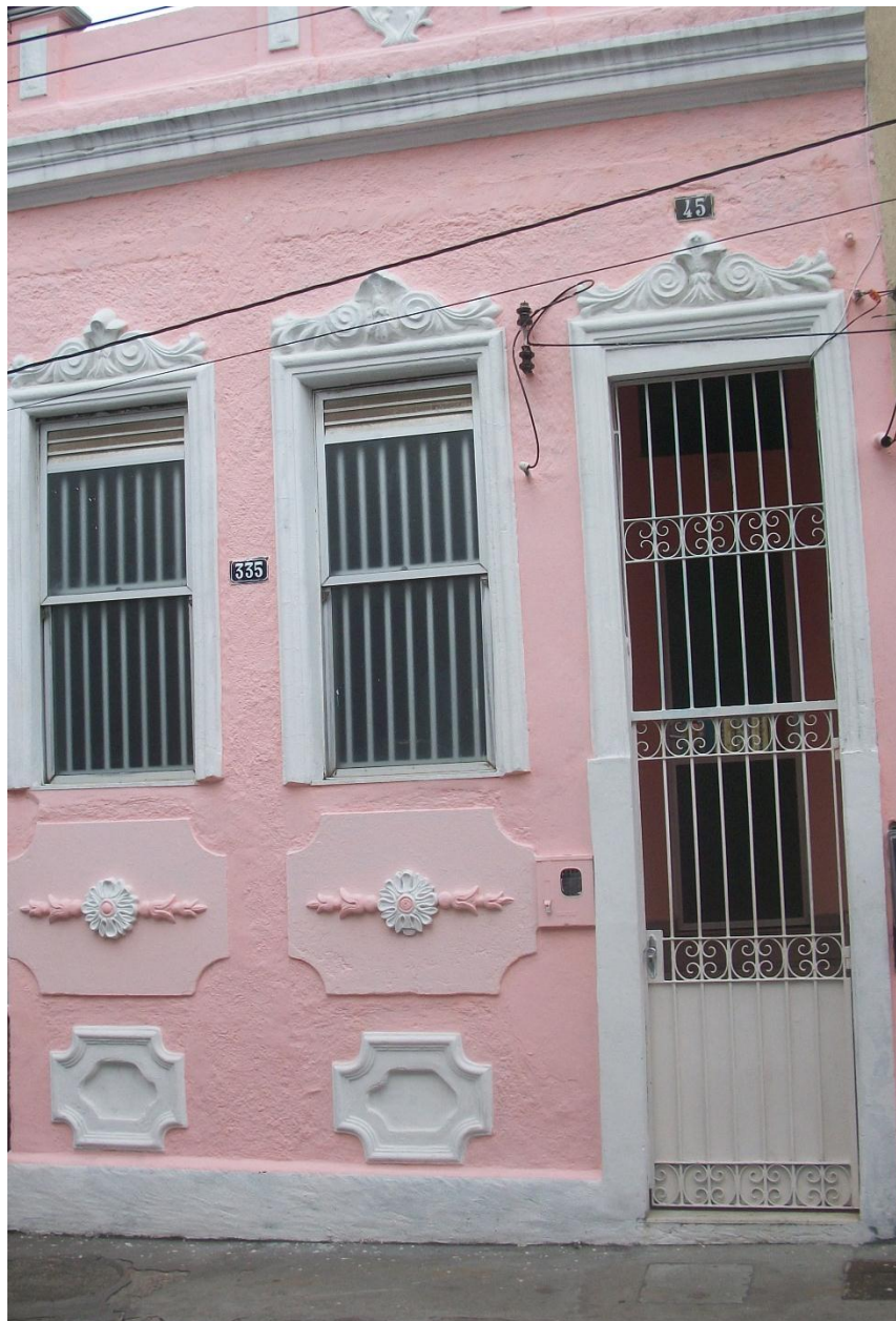
Figura 2. Casa na Rua Jogo do Carneiro, onde Luís Xavier também tinha um imóvel, no século XIX. Fonte: Pesquisa de campo realizada em 07/12/2013.
